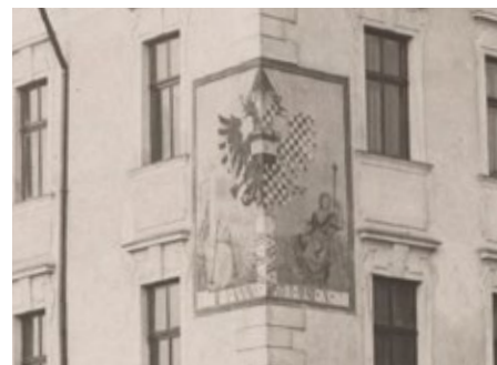
Detail fotografie z počátku 20. století ukazuje původní podobu nárožních hodin.
