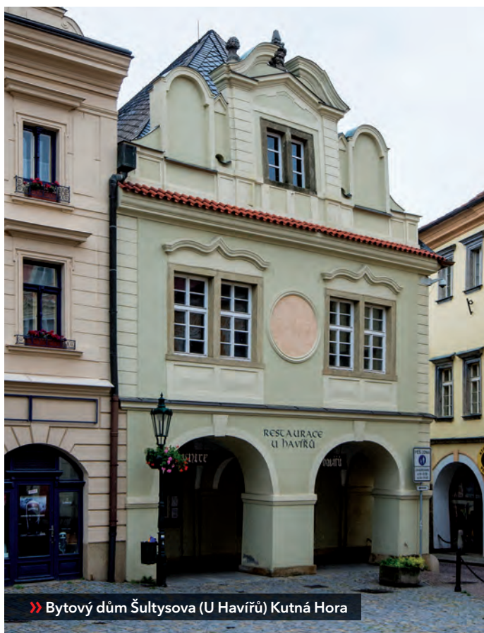
» Bytový dům Sušilova Vsetín
